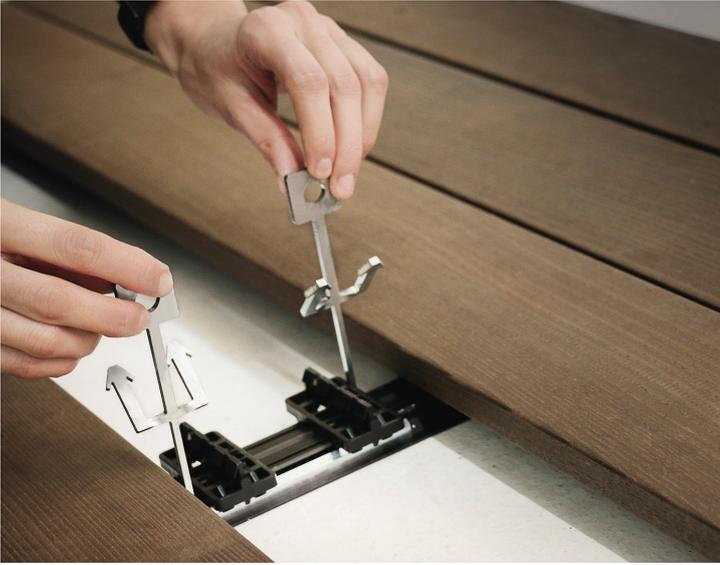
Der Grad Clip ist bereits ab Werk vormontiert. Er ist ebenso demontierbar, selbst mitten in der Fläche. Seine Flügel spreizen sich in der Nut und füllen diese komplett aus. Automatisch perfektes Fugenbild.
